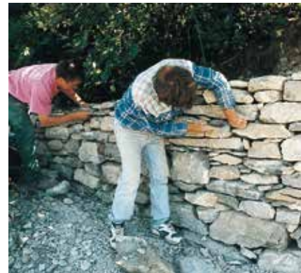
Wiederaufbau der Trockensteinmauern
